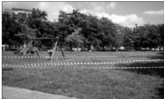
Il «Manaresi» recintato per l'inizio dei lavori
